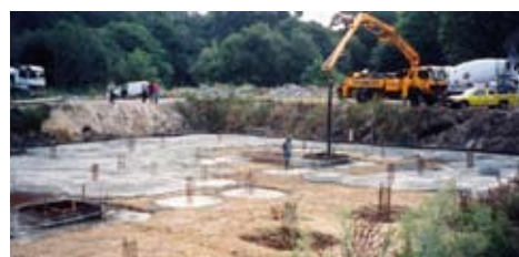
Instalacja wspartej na słupkach płyty TAB-Raft® – 65 kg/m 3
