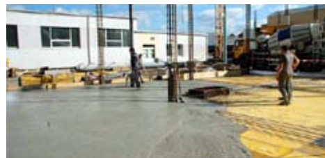
Instalacja płyty TAB-Slab®, w której użyto 100 kg włókien na metr sześcienny
