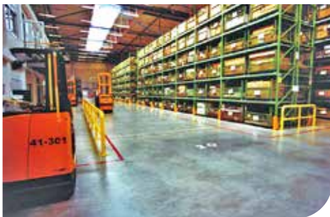
Industrieböden mit hohen Verkehrs- und Punktlasten
