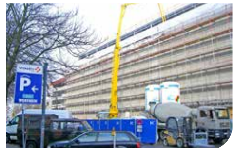
Parkhausdächer mit großen Feldabmessungen und Lastverteilerplatten
