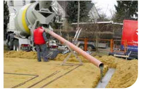
Fundamente, Dresden (D)
