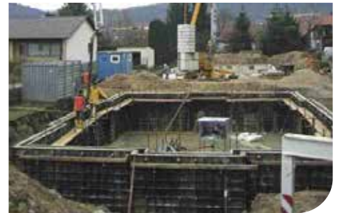
Kellerwände einer weißen Wanne, Regensburg (D)
