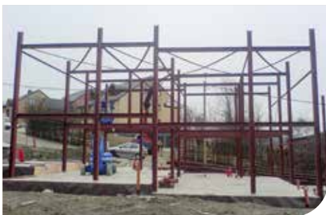
ArcelorMittal Steel House, Tilleur (B)
