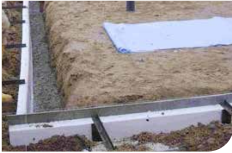
Streifenfundamente, Roggentin (D)
