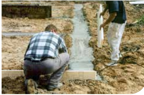
Fundamente eines Wohnhauses, Greifswald (D)
