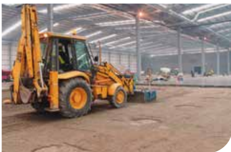
Pfahlgestützter Industrieboden, Carlsberg (UK)
