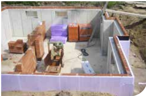
Kellerwände eines Wohnhauses, Pfreind (D)
