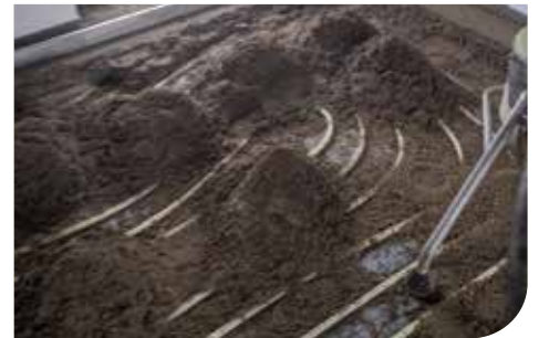
Estrich mit Fußbodenheizung (B)
