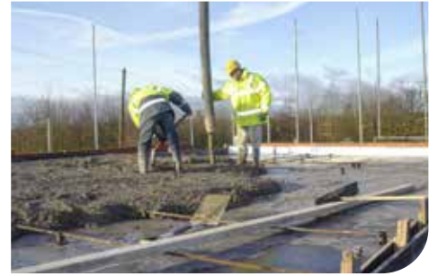
TAB-Slab™, Birmingham (UK)
