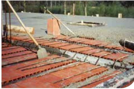
Geschossdecke mit Halbfertigteilen (B)
