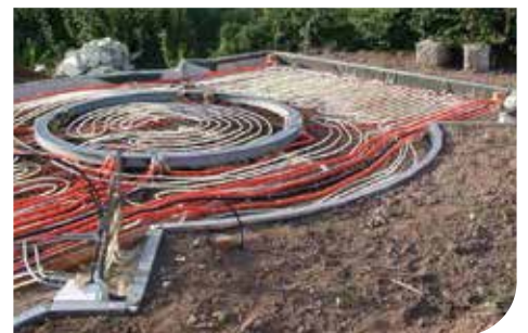
Bodenplatte mit integrierter Fußbodenheizung, Bendorf (D)
