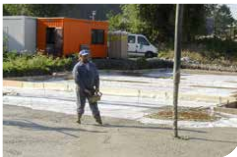
Bodenplatten für Wohnhaus, Jambes (B)
