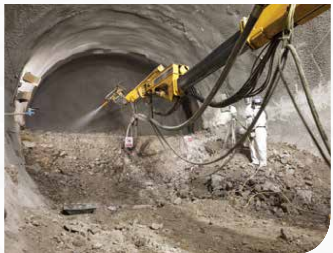
Travaux de béton projeté avec fibres en acier, Crossrail, Londres © Crossrail Ltd.
